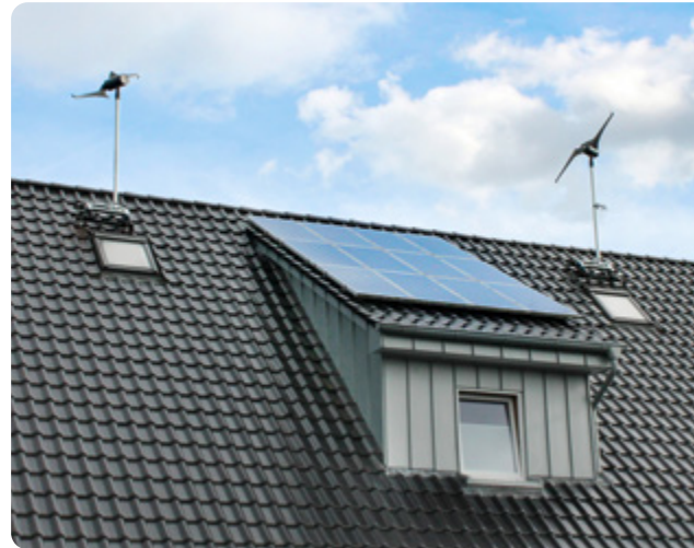
Entkoppelte Aufdachmontage auf Solarschiene (S. 63)
